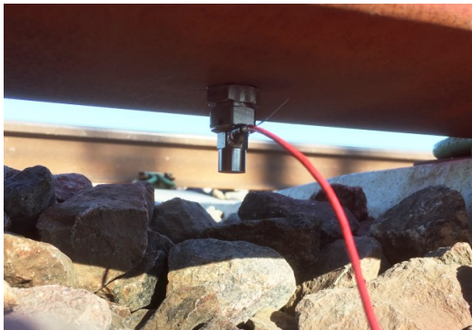
Foto 2: Accelerometer monterad under rälfot mätplats Skårby, Bohusbanan
